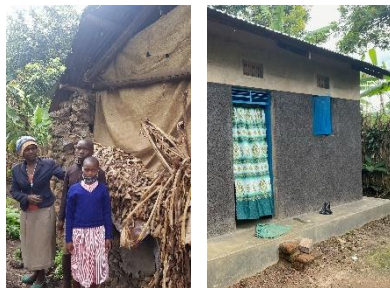
Alte Hütte im März – Neubau im Juli
